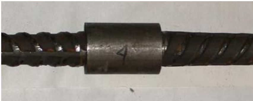
б) - переходное соединение с цилиндрической резьбой
